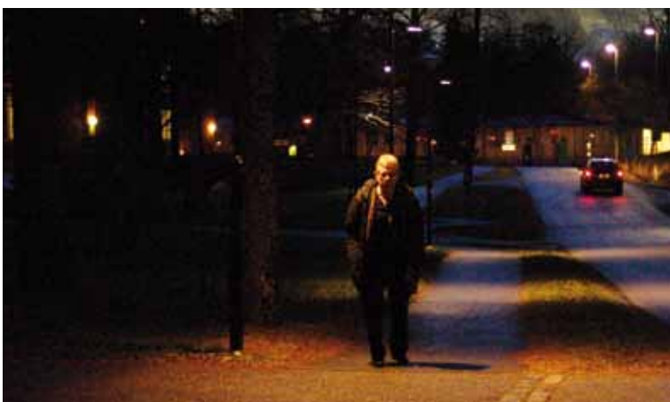
Gångvägarna får nedåtriktat ljus som gör att man ser marken, och därmed gående. I bakgrunden traditionell belysning där marken inte syns.
